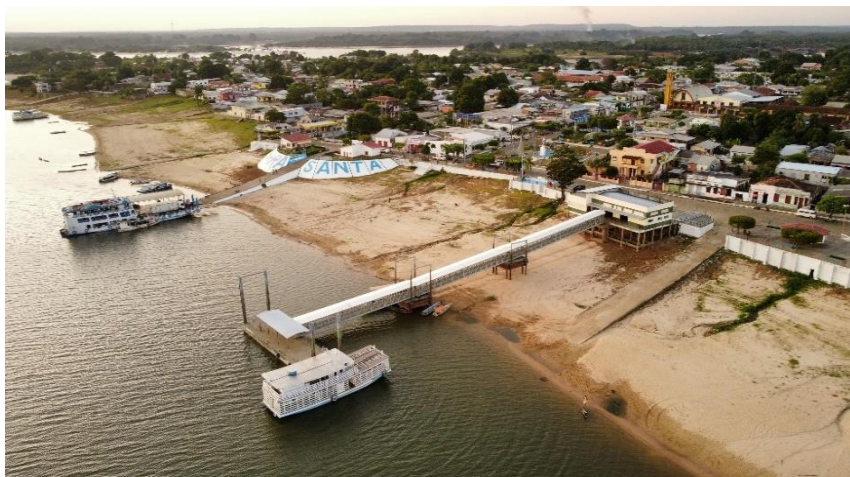
Figura 24 - Rampa de embarque/desembarque Hidroviária de Terra Santa
